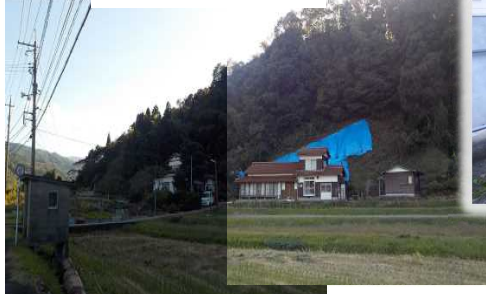
崩壊斜面へのシート張り
