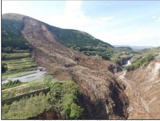
大規模な崩壊事例（阿蘇大橋地区）
