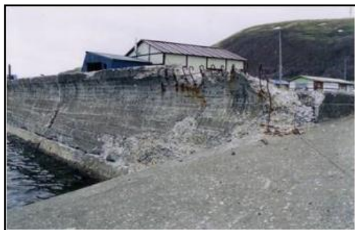
老朽化した海岸堤防
