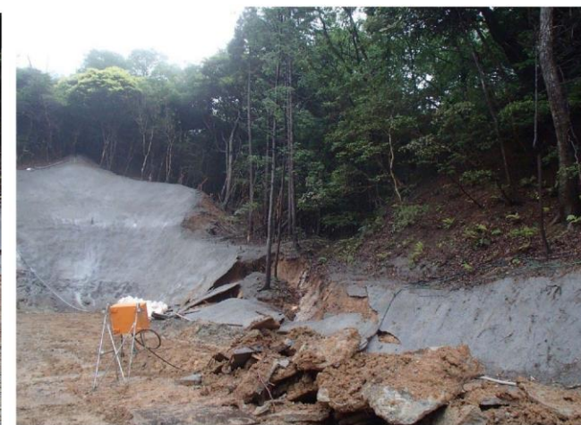
No315+80～315+90、坑口左の谷部切土斜面 拡大崩壊
