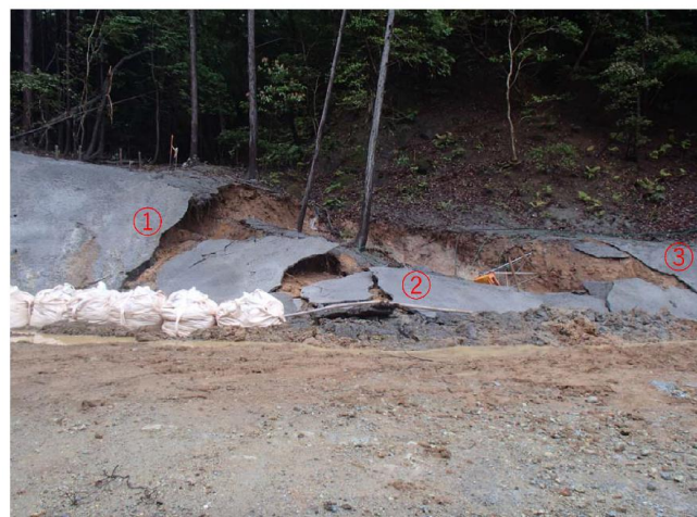
No315+80～315+90、坑口左の谷部切土斜面 拡大崩壊
